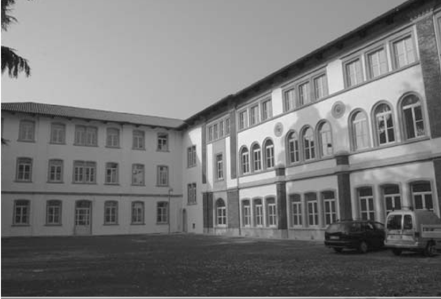
Il complesso ristrutturato delle ex scuole Blanchini e Margreth.
